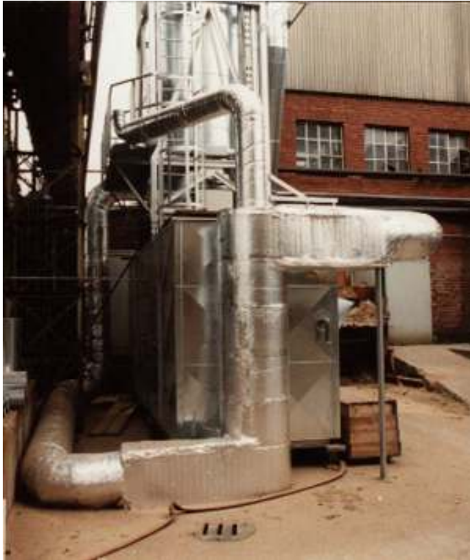
Bild 4: Wirbelrohr-Staubabscheider für einen Durchsatz von 5000 m 3 /h
